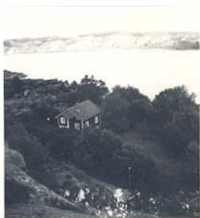
DERAS HUS I STENSJÖ
